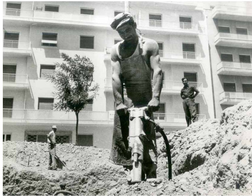
Arbeiders werken aan de fundering van een nieuwe polykatikía , begin jaren '50.
